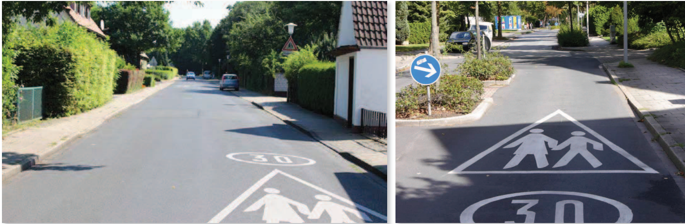
Abb. 40+41: Fahrbahnmarkierungen am Salzweg (l.) und an der Berliner Allee (r.) Fotografie: plan-lokal
