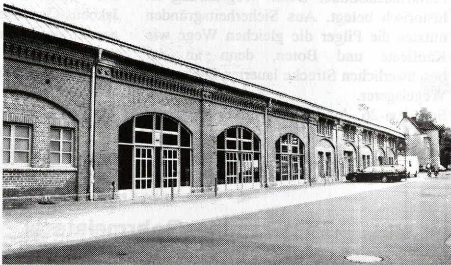
Rohrmeisterei, ein typischer Bau früher Industriearchitektur
