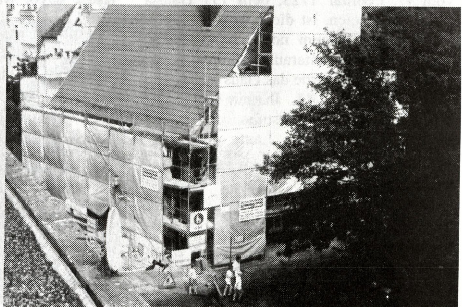
Renovierungsarbeiten im Sept. 2002
